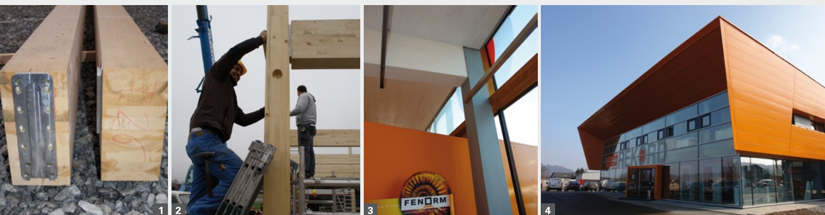
1) SHERPA verbinder XL70 wurden bereits in der Vorfertigung montiert um 2) an der Baustelle rasch und effizient montiert zu werden. 3) Die Rahmenecke im Schauraum – verdeckt ausgeführte SHERPA-Verbindung 4) architektonisch ansprechender Holzbau: das neue Schauraum- und Bürogebäude von REKORD-Fenster in Wildon
